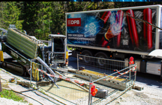
Horizontalbohrverfahren
